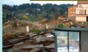
被災直後の旧山古志村内の状況
