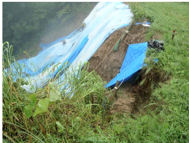
図5 はがね山送信所付近での台風被害(2018年7月豪雨 6月28日～7月8日) (左:「白糸の滝」山側の市道 右:送信所敷地内の南側法面)
