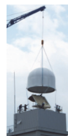
図 4 大阪大学に設置 中の次世代ドッ プラーレーダ
